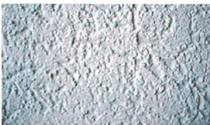
Nordseite des „Hochhaus Am Brunnen“. Vor rund 3 Jahren wurde die Fassade mit der Beschichtung von Bioni-Shield versehen. Die Nahaufnahme (kleines Foto) zeigt eine noch immer algenfreie Fläche.
